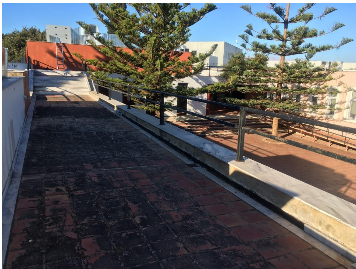
Εικόνα 2_ Υφιστάμενη κατάσταση πλακιδίων Κυλικείου
