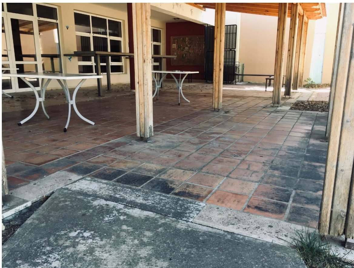
Εικόνα 2_ Υφιστάμενη κατάσταση πλακιδίων Κυλικείου
