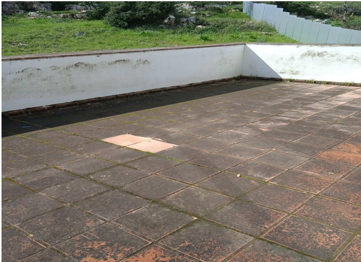
Εικόνα 5_ Υφιστάμενη κατάσταση πλακιδίων Νότιας βεράντας Εστιατορίου
